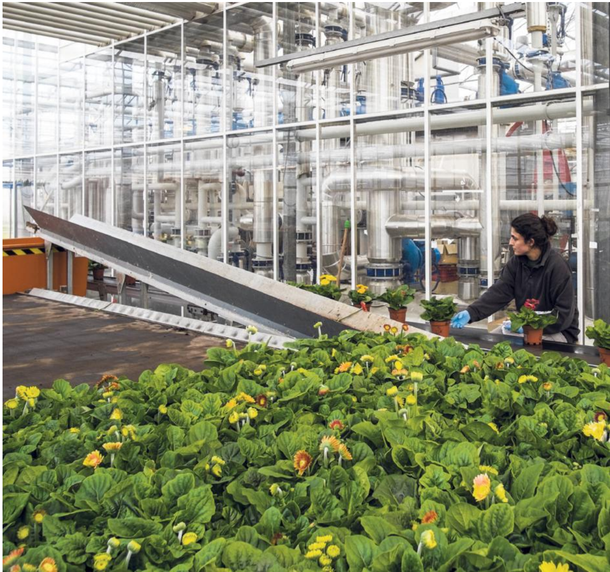
De kassen van Globe Plant in Vierpolders op Voorne-Putten worden op de juiste temperatuur gehouden door gebruik te maken van aardwarmte.
