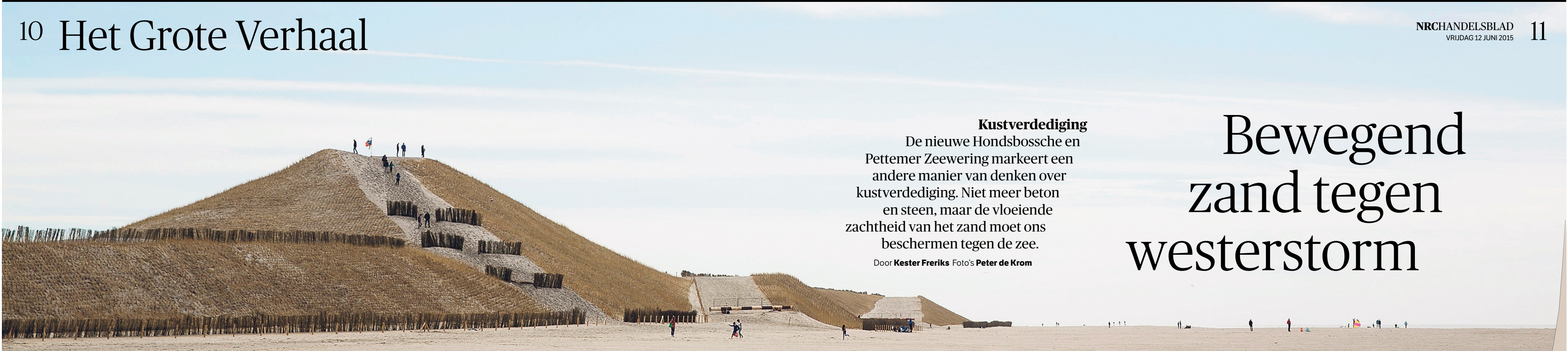
Het hoge Panoramaduin, aangelegd op verzoek van de bewoners van Petten. Het zand is verstevigd met jonge aanplant van helmgras en gevlochten wilgentenen. Op de top wapperen de vlaggen van aannemerscombinatie van Oord-Boskalis.
